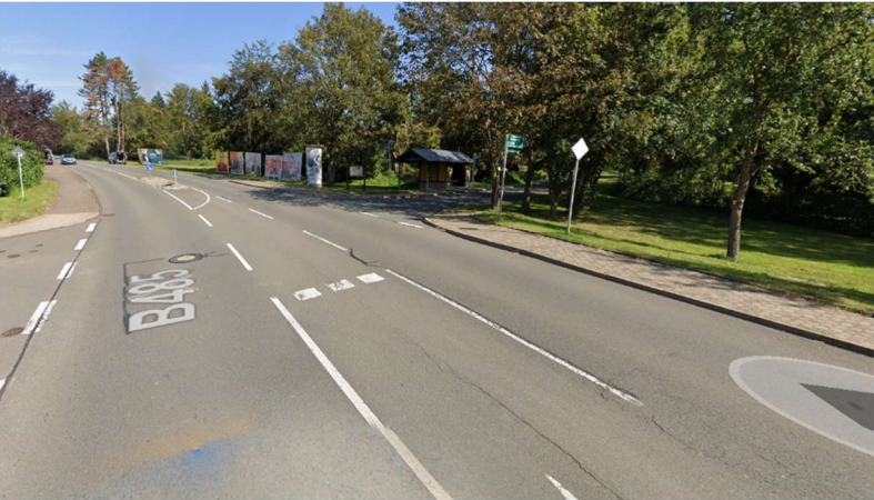
3 Kreuzung B 485 Edertalstraße / Klosterweg (Bushaltestelle) / Fombachstraße
