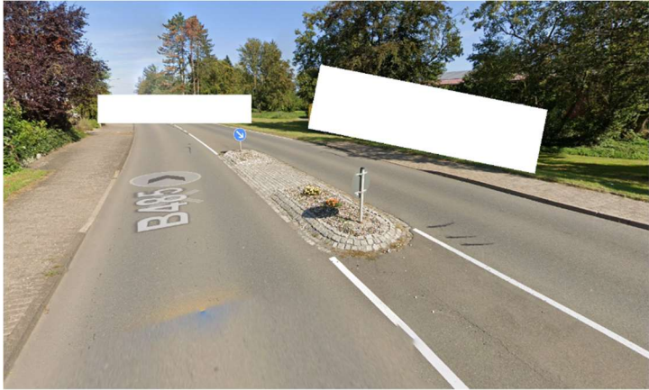
2 Querungshilfe Edertalstr. B 485
